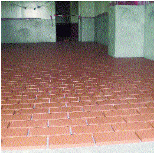
Bild 1. Auskleidung mit säurefesten Fliesen mit darunter liegender Abdichtung
